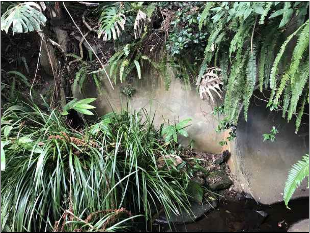
PHOTO E2 CULVERT WATERWAY
