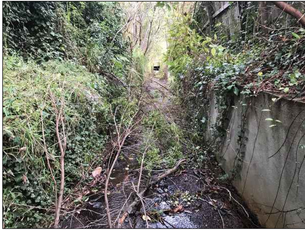
PHOTO E1 CULVERT - DOWNSTREAM
