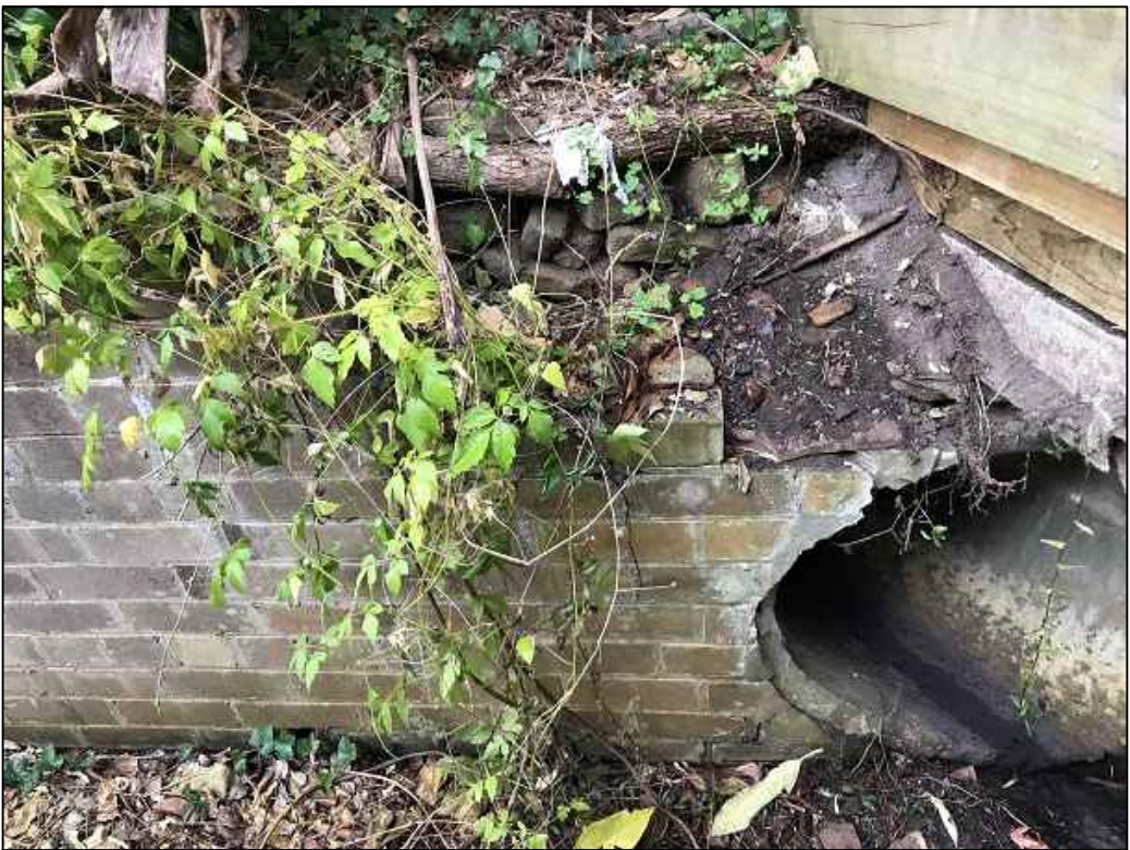
PHOTO E3 - DRAINAGE PIPE
