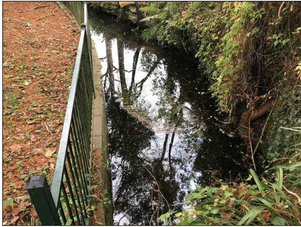
PHOTO F1 CULVERT - DOWNSTREAM
