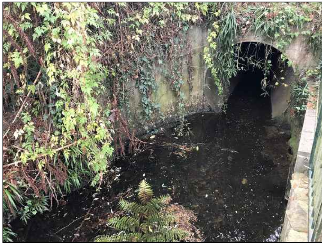
PHOTO F1 CULVERT WATERWAY
