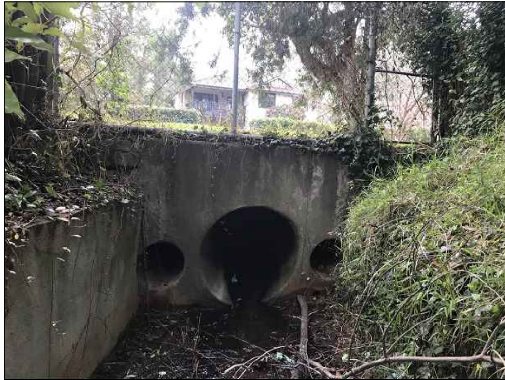
PHOTO E1 CULVERT - UPSTREAM
