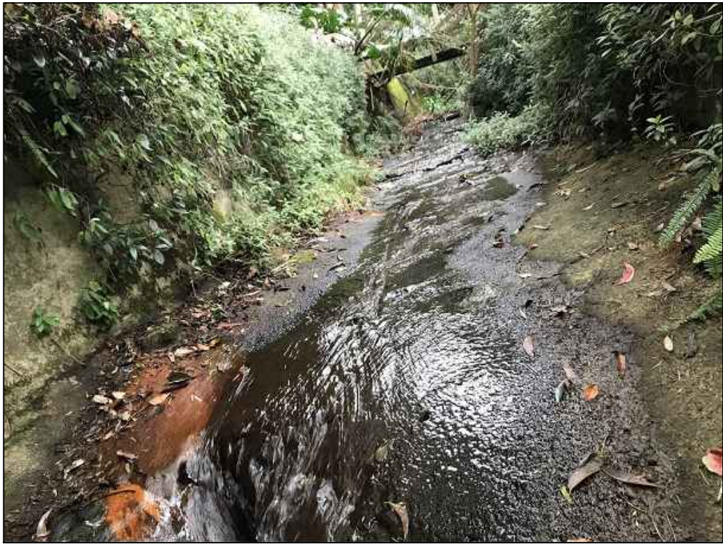
PHOTO E2 CULVERT - UPSTREAM
