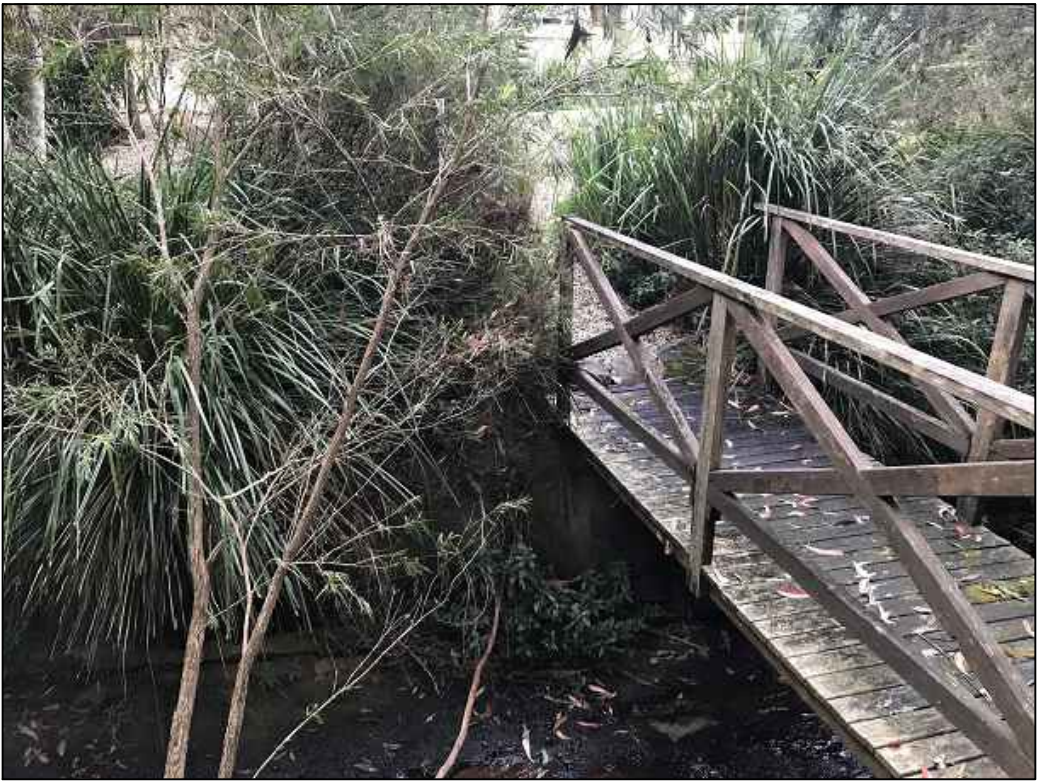
PHOTO E2 WATERWAY
