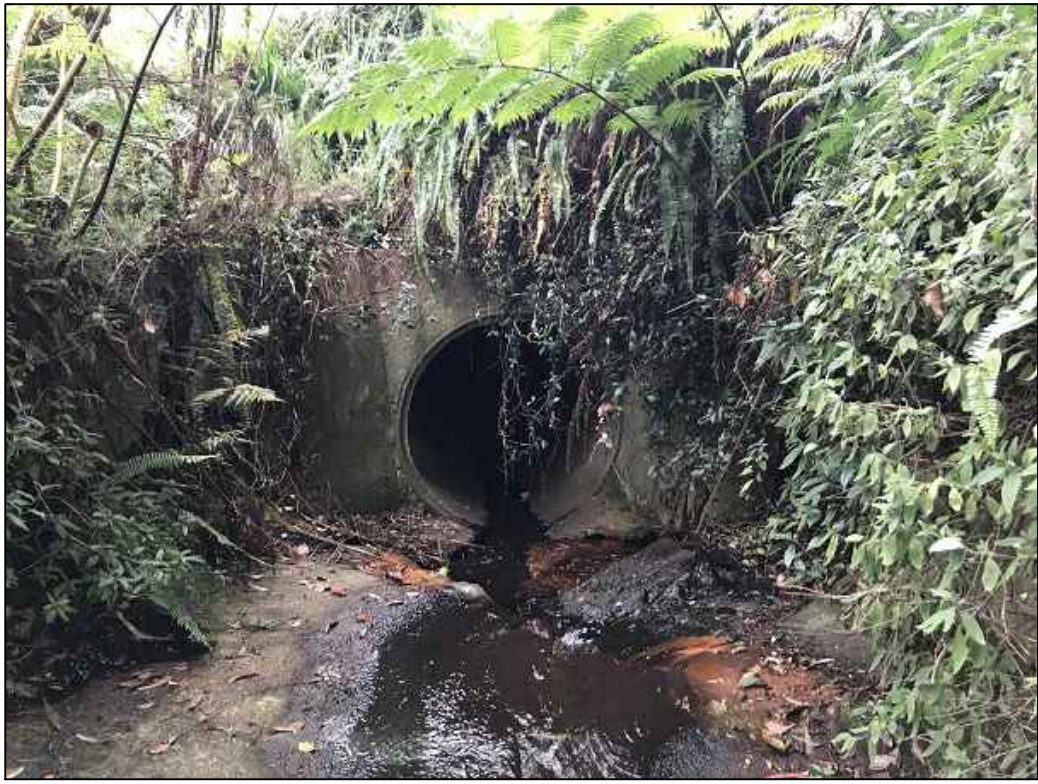
PHOTO E2 CULVERT - DOWNSTREAM
