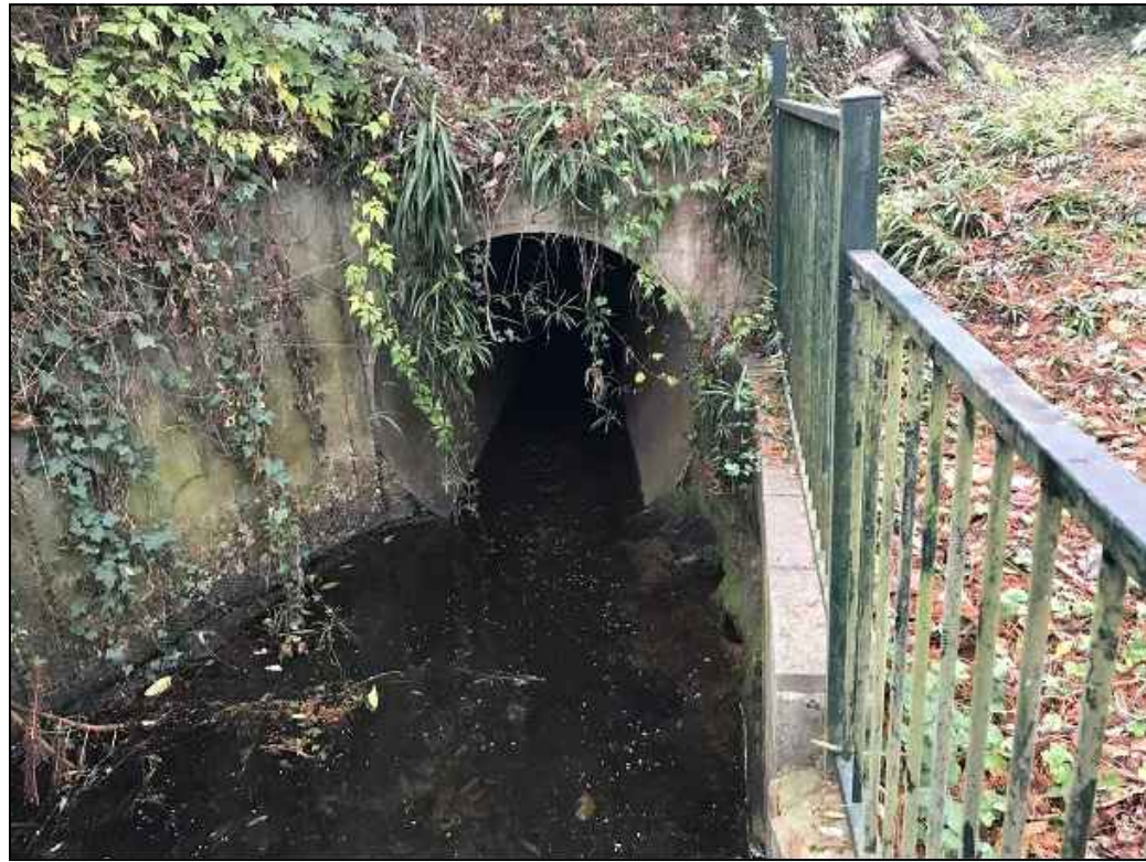
PHOTO F1 CULVERT - UPSTREAM
